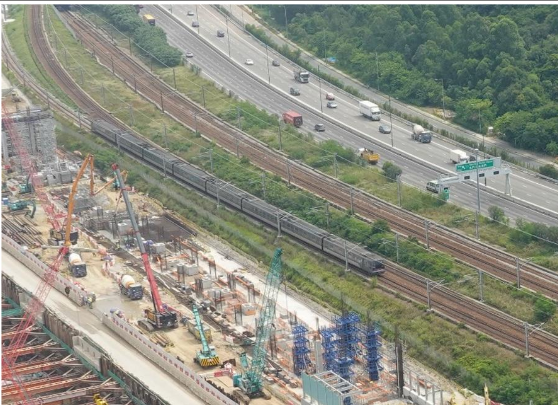
東涌東站施工進展
