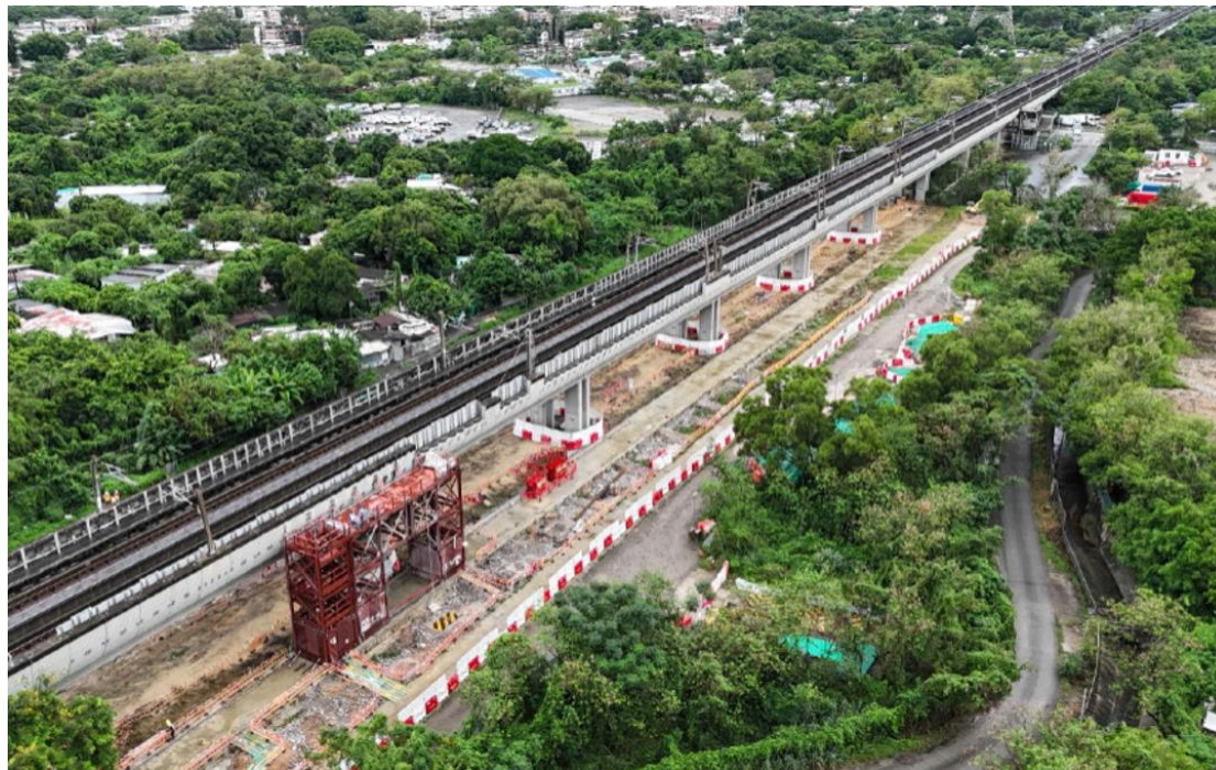
洪水橋站：正進行車站的前期工程
