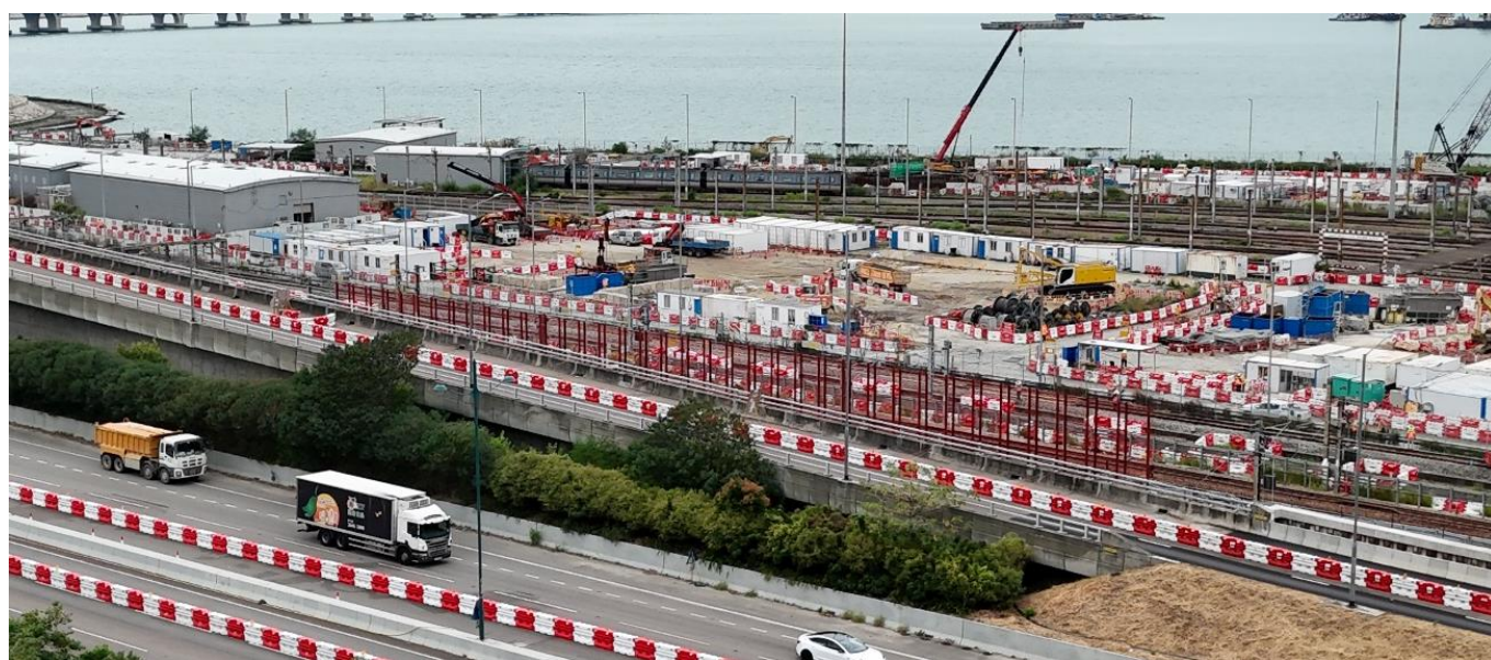
小蠔灣站施工進展
