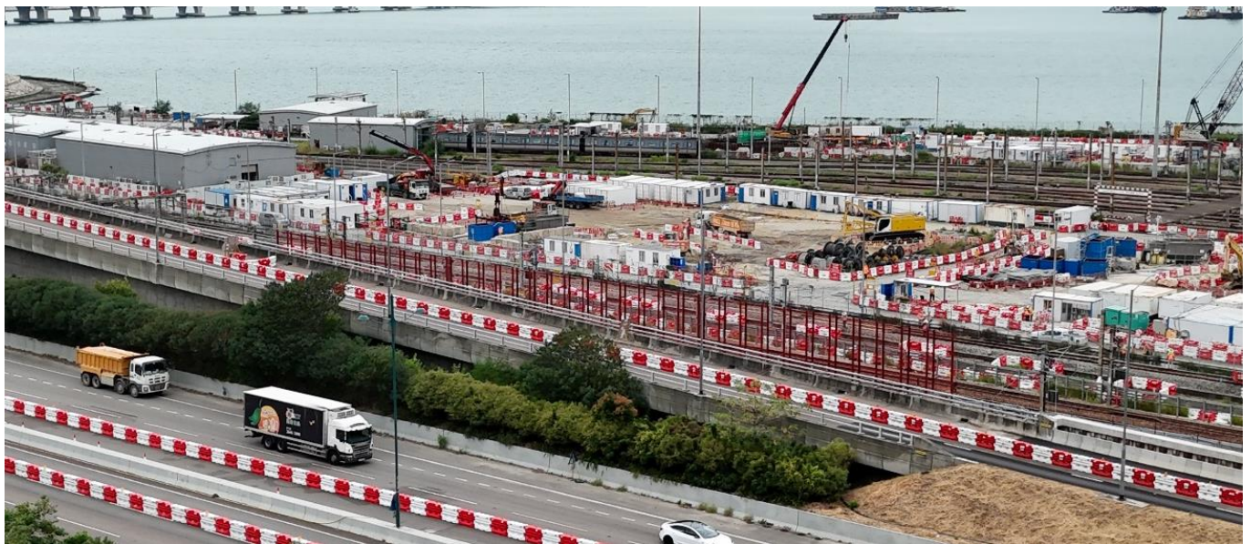
小蠔灣站施工進展
