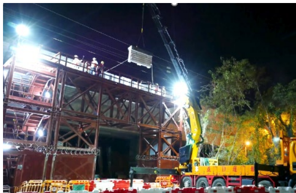
屯馬綫洪水橋站 - 移除高架橋護牆 Hung Shui Kiu Station – parapet removal
