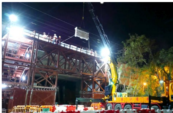
屯馬綫洪水橋站 - 移除高架橋護牆 Hung Shui Kiu Station – parapet removal
